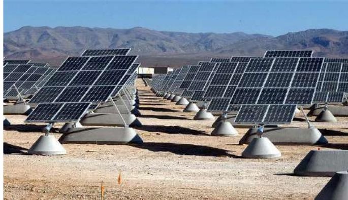
**Fig: 1.5.2.a) Typical Polar Trackers**
