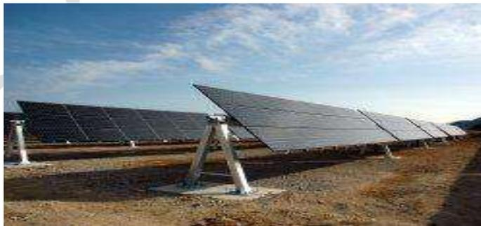
**Fig: 1.5.2.b) Horizontal Axle Trackers**
